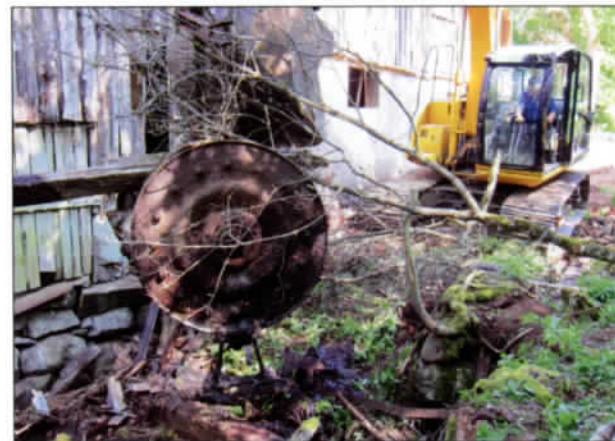
Turbinen lyfts ur rännan.
