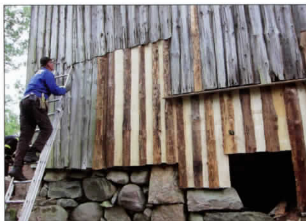
Leif Lorén har "skött och bött" väggen på baksidan.
