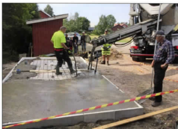
Betongplatta gjuts till WC.
