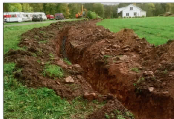
Dikesgrävning för vatten och avlopp vid Mölarp. Foto: Sven-Åke Johansson.
