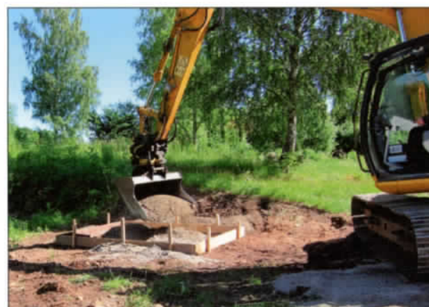
Bottenplattan till turbinen, Björn Samuelsson med sin grävska. Foto: Sven-Åke Johansson.
